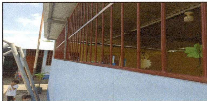
Foto 3: Sustitucion de Balcón
