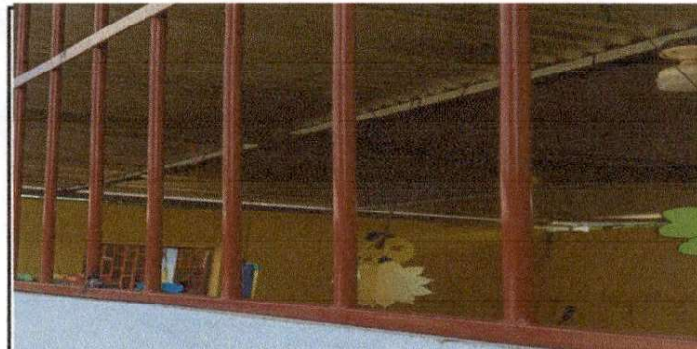
Foto 4: Sustitucion de Balcon
