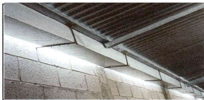
Foto 5: Colocación de Canal, para recibir Agua parte trasera de Dirección, Aula 3, Aula 2, Aula 1, Aula 1 Párvulos
