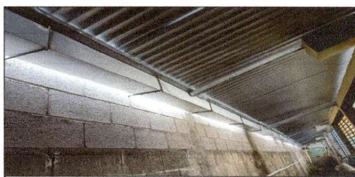
Foto 6: Colocación de Canal, para recibir Agua parte trasera de Dirección, Aula 3, Aula 2, Aula 1, Aula 1 Párvulos
