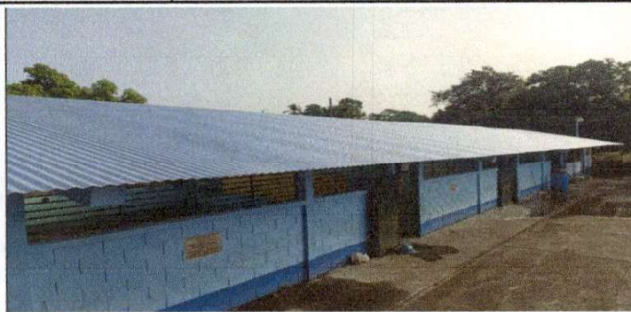
Foto1: Sustitucion de Lámina en Dirección, Aula 3, Aula 2, Aula 1, Aula 1 Párvulos
