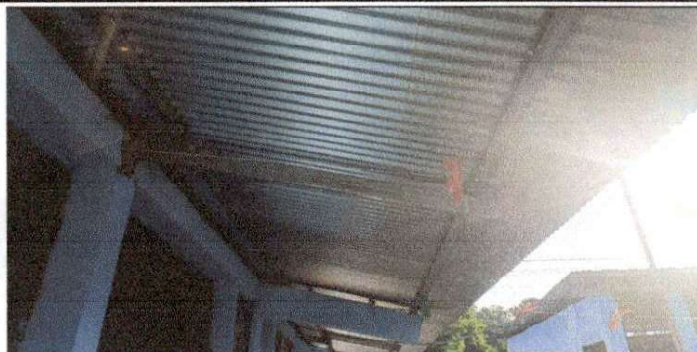
Foto 2: Sustitucion de Lámina
